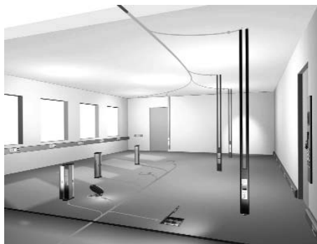
Рис. 12.1. Варианты подвода коммуникаций к местам подключения потребителя
